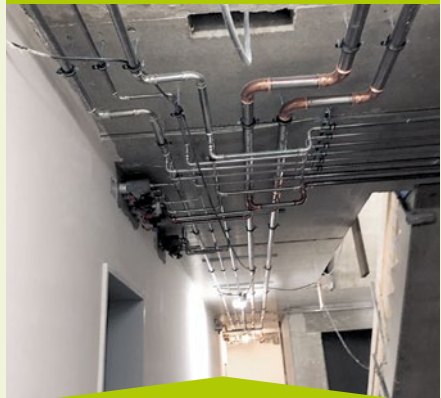
Januar 2021 – Das wird warm: Wasser und Heizung in Rohinstallation.
