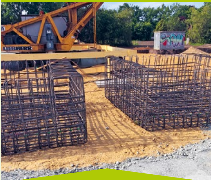
Mai 2020 – Unten für oben klarmachen: Hier entstehen Aufzüge.
