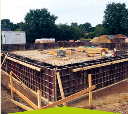
Juni 2020 – Die Frostschürzen sind eingeschalt.
