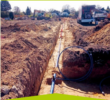
April 2020 – Grundlagen schaffen: Leitungen durchziehen das Baufeld.
