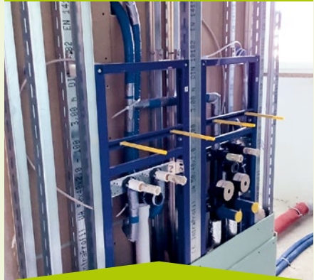
Februar 2021 – Sieht noch nicht so aus, wird aber ein Waschbecken.
