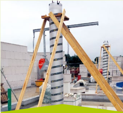
Juli 2020 – Aufwärts: Auch die geschalteten Stützen zeigen die Baurichtung an.
