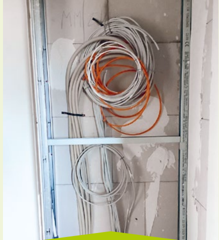
März 2021 – Unter Hochspannung wird an der Elektrik gearbeitet.
